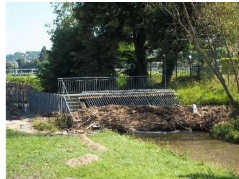
Figure 104 : Dégrilleur du Tillet
