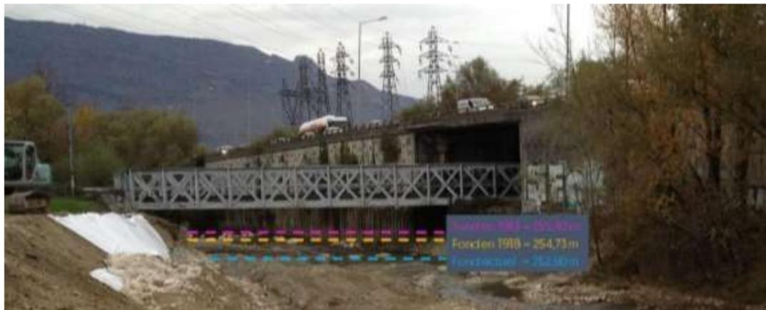
Figure 55 : Evolution du fond de la Leysse, sous le pont SNCF à Chambéry
