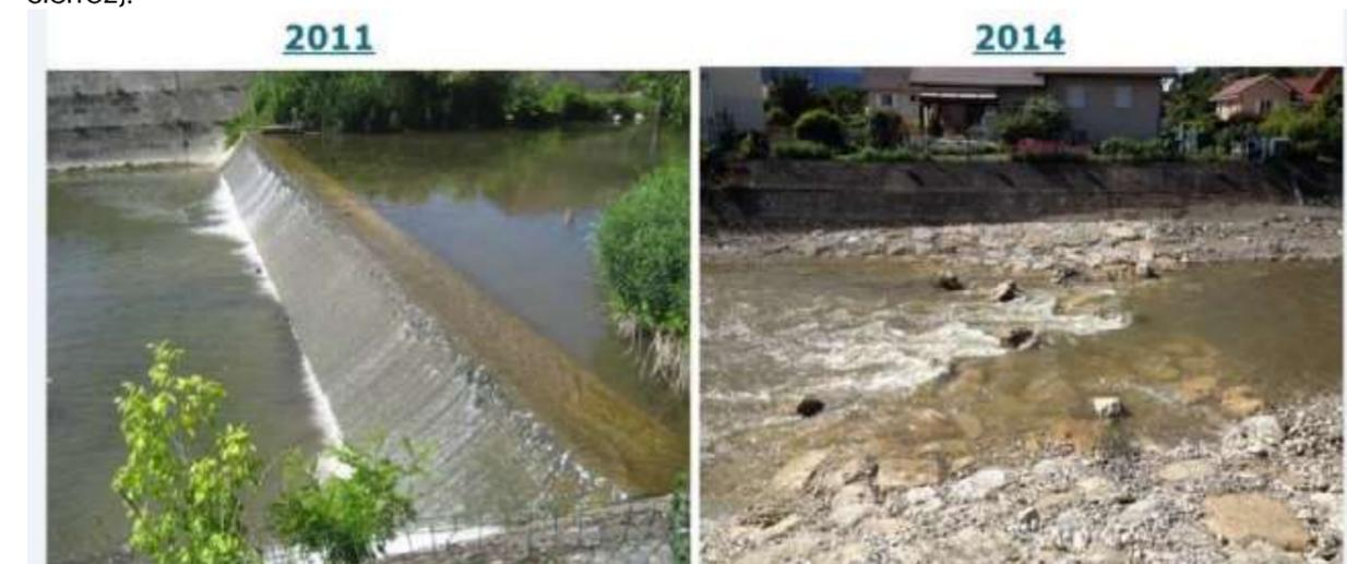
Figure 36 : Restauration du seuil du Pont Rouge (Aix-les-Bains)
